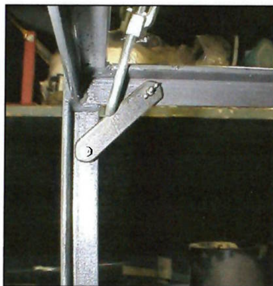
Figura 5.12.2 – Trava de segurança do esticador aplicada.
